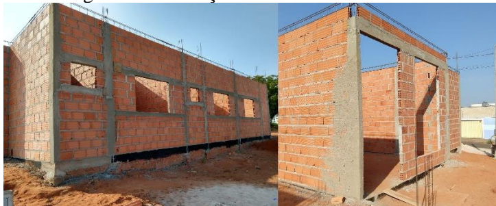
Figura 1. Construção da residência unifamiliar
